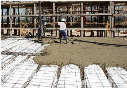
En ella se establecen los requisitos para bovedillas y casetones que vayan a ser utilizados en forjados cuyos nervios vayan a ser hormigonados en obra. Los forjados pueden ser tanto unidireccionales como bidireccionales, comúnmente conocidos como reticulares.
